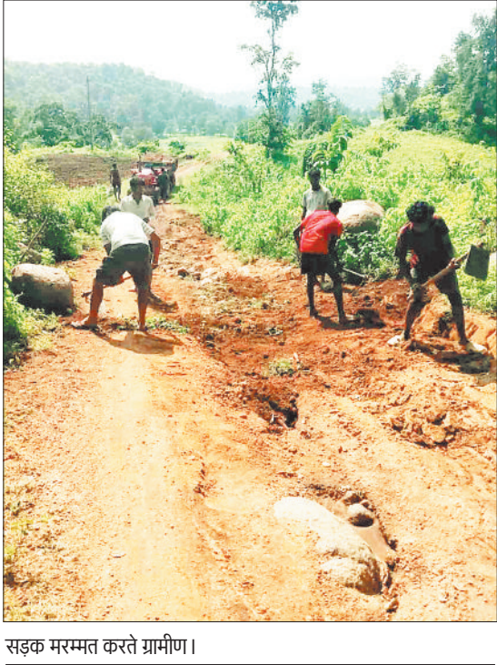
सड़क मरम्मत करते ग्रामीण।
